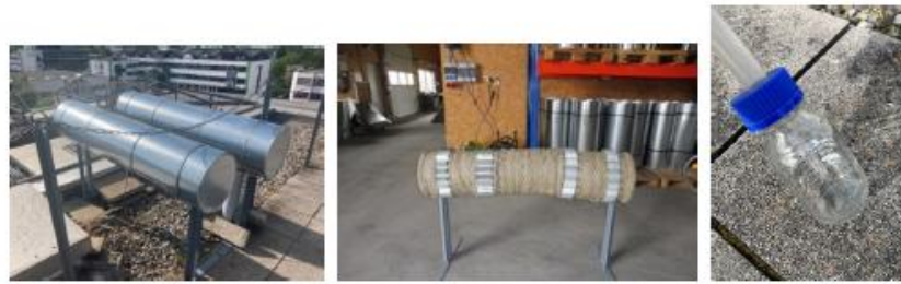
Bild 2: Links: Zwei gedämmte Rohrprüfstände mit und ohne Luftspalt auf dem Institutsdach Mitte: Dämmaufbau ohne Ummantelungsblech mit Abstandshaltern für den Luftspalt Rechts: Kontrollglas für Tauwasseranfall
