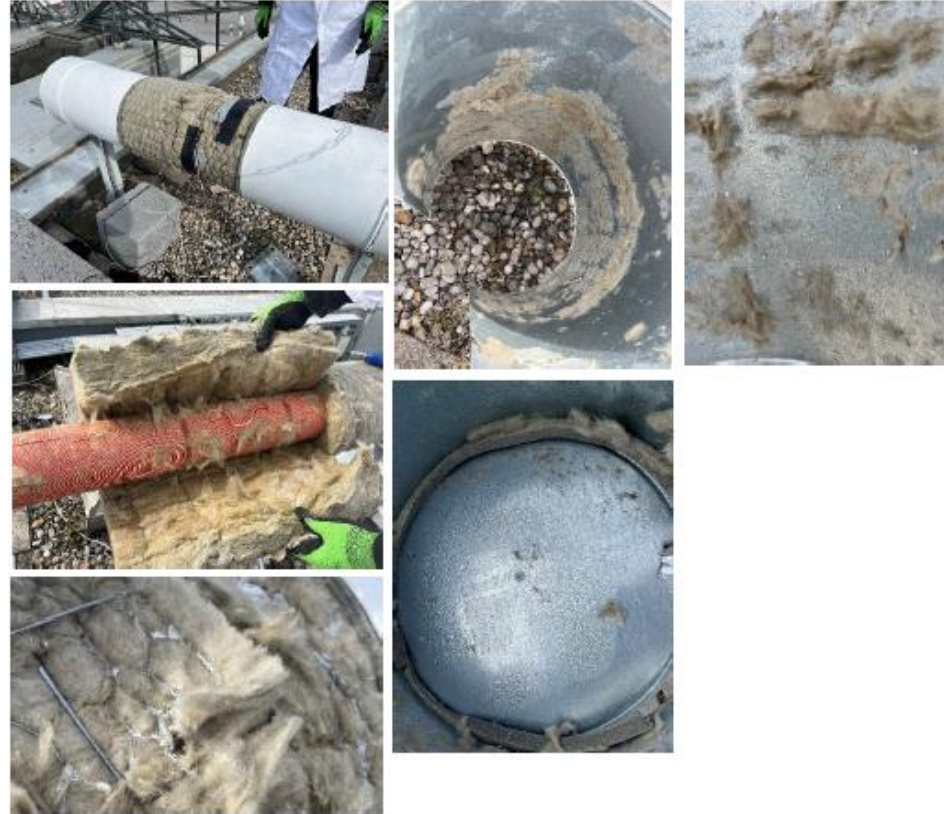
Bild 8: Geöffnetes Rohrdämmsystem ohne Luftspalt.
