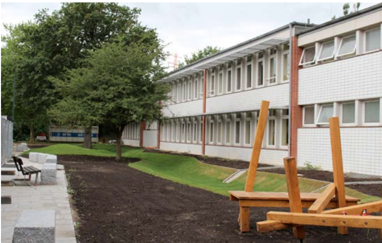
Der Schulhof in der Umgestaltung. Im Hintergrund ist eine Regenwassermulde mit den offenen Zuläufen zu erkennen; im Vordergrund ein Balancierparcours und links am Rand Sitzsteine (Foto: BSU)
