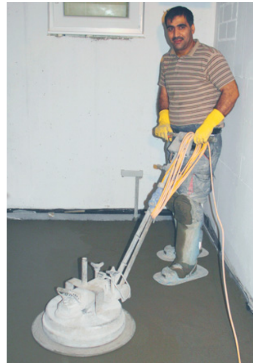
Reiben der Estrichoberfläche mit der Tellermaschine
