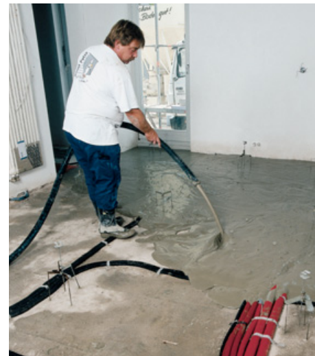
Einbauen von Ausgleichsmörtel
