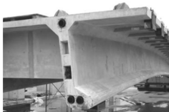
Abb. 1: Bauzustand - Brücke des Friedens in Seoul - filigrane Bauweise als \pi -Querschnitt mit nur 16,0 cm breiten Steg [3]
