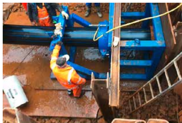
Abb. 1: Relining ohne Ringraum im Kaltreduktionsverfahren
