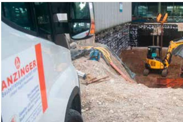
Für die Vorbereitung der Baugrube hat die Firma Anzinger erstmals volldigital einen Bagger bei klarx gemietet.
