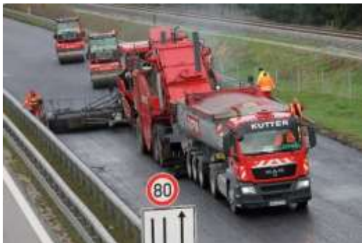
Abb. 1: Asphalteinbau unter Einsatz von Beschicker und Thermomulde
