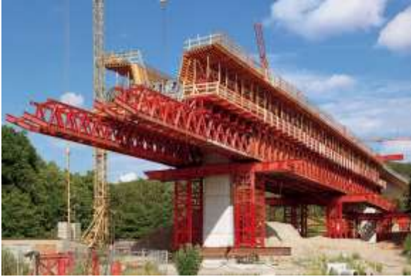
Abb. 1: Unten laufende Vorschubrüstung Quelle: PERI GmbH, Weißenhorn, Deutschland
