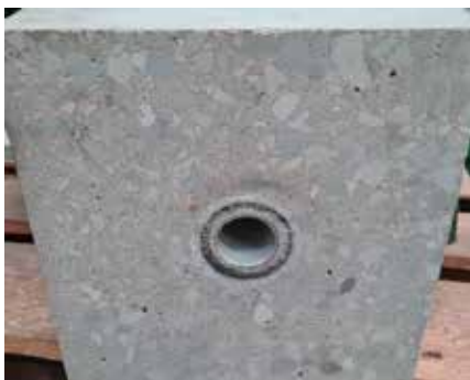
Abb. 1: Betonoberfläche nach dem Schleifen
