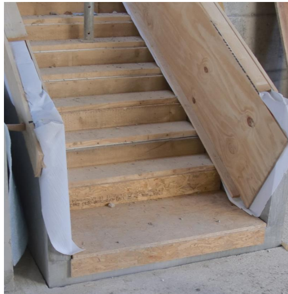
Abbildung 2 - Schutz von Sichtbetontreppenläufen (Quelle: Wayss & Freytag Ingenieurbau AG)
